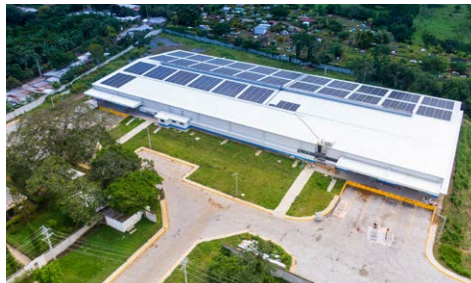
니카라과 법인 태양광 패널
